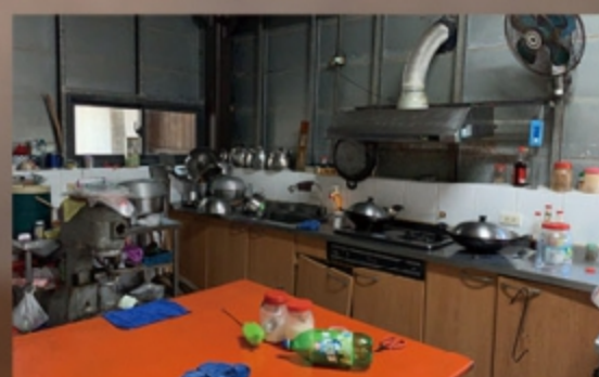
▲ 櫥櫃損壞嚴重
