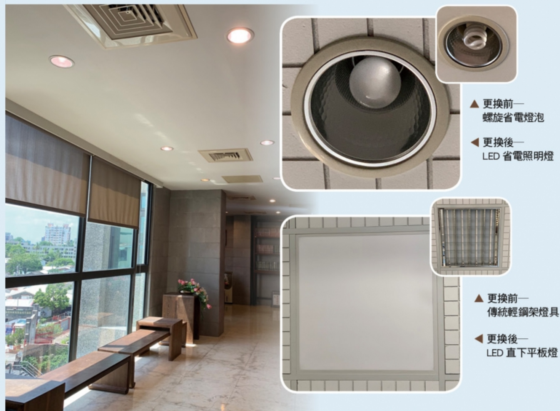
▲ 整棟建築物的照明皆更換為具節能環保標章之燈具（燈泡近 200 顆、輕鋼架燈具 90 組）
