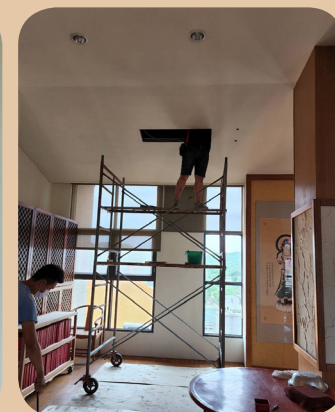
◀ 五樓禪堂更換冷 氣風管並重新安 裝維修孔
