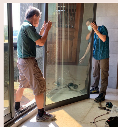
▲ 更換落地玻璃門磨損之滾輪
