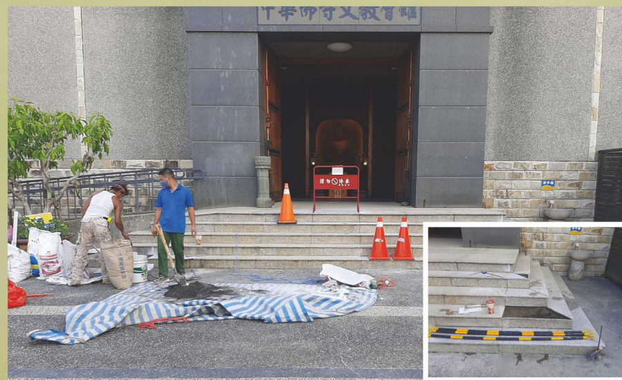
▲移除並更換破損之階梯石板
