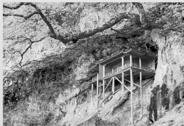
▲日本佛教 | 三德山三佛寺 三佛寺位於鳥取縣的三朝町、標高900 公尺的三德山境內，據傳於706 年由修驗道的創始者所建，自古就被當作是神聖的靈山崇拜。三德山上座落著無數的寺廟，其中最著名的就是座落在懸崖絕壁上的「投入堂」，因為地勢險峻，更有日本最危險的國寶之稱。
