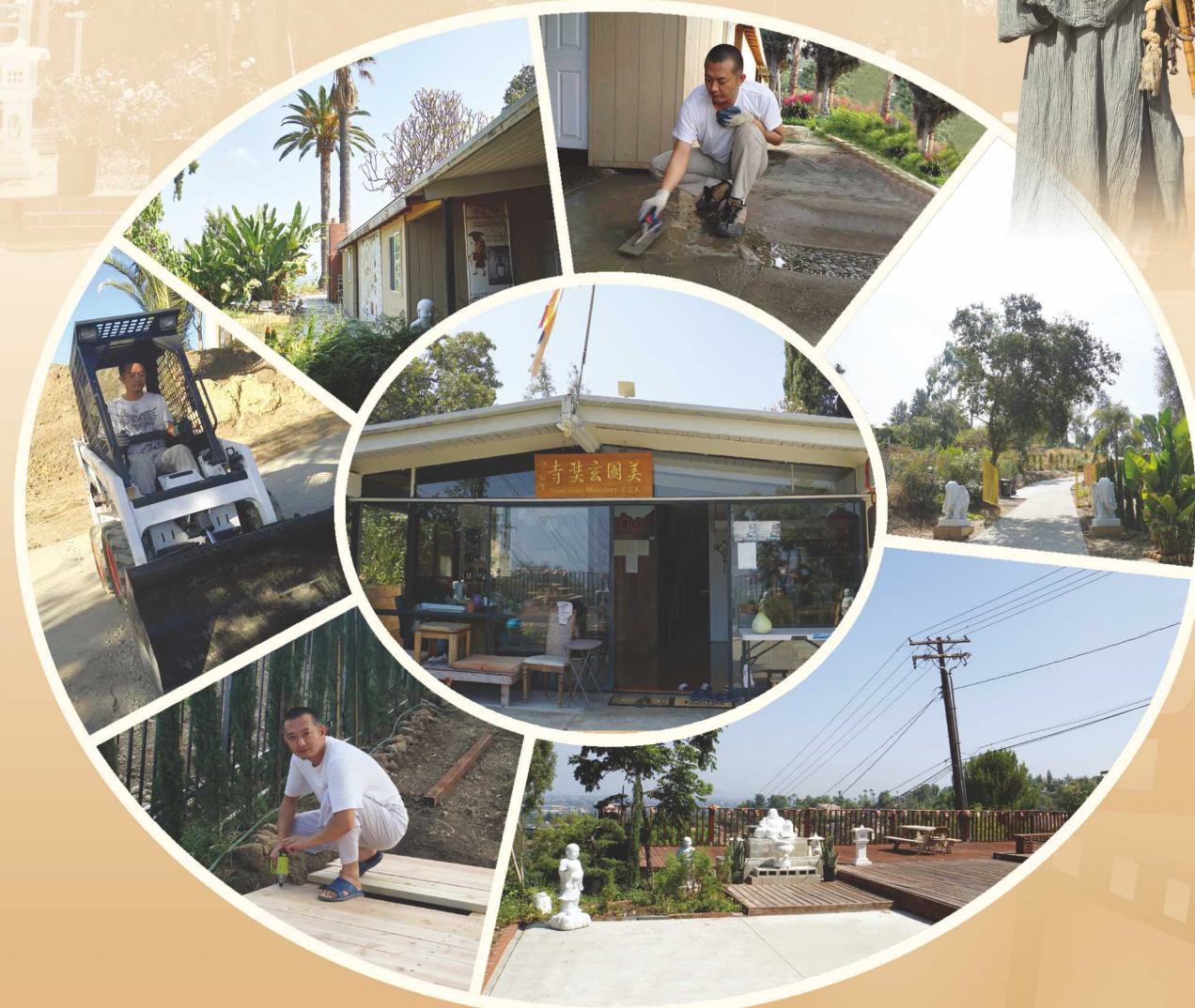
▲ 心海法師親力親為～美國洛杉磯玄奘寺刻正進行整地、鋪路等重建工程
