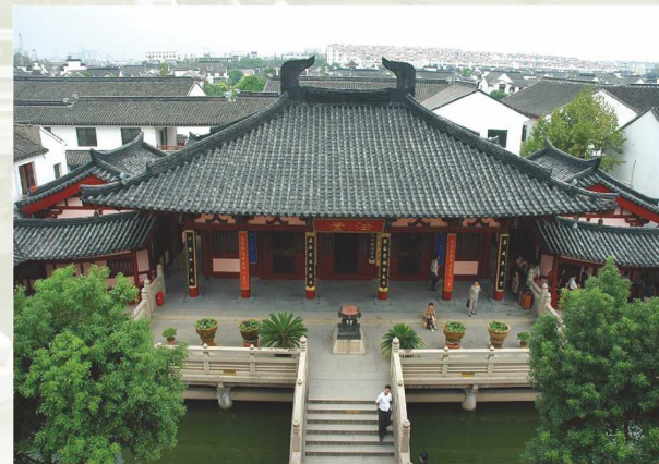
▲法堂前闢有露台，下面碧池環繞，露台正中立九龍五鳳青銅寶鼎。
