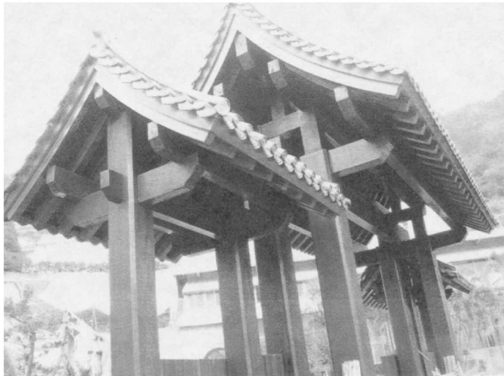
▲耗費巨資興建的木造牌樓
