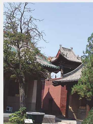
▲雙林寺現存建築主要為明代和清代所修建。
