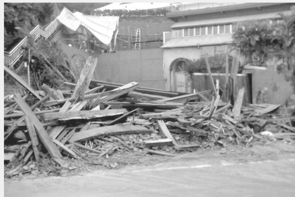
▲九十七年一月卅一日遭台北縣政府拆除大隊執行拆除
