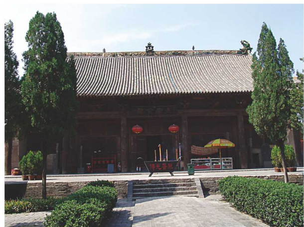
▲雙林寺坐北朝南，沿中軸線座落著三進院落，十座殿堂
