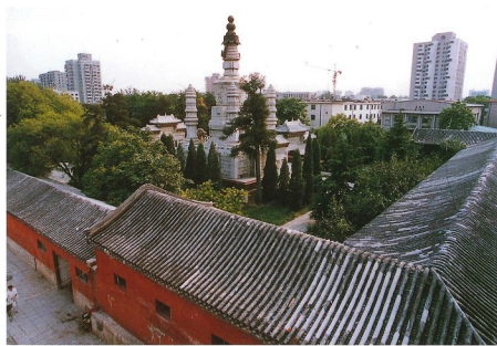
▲清淨化城塔全貌
