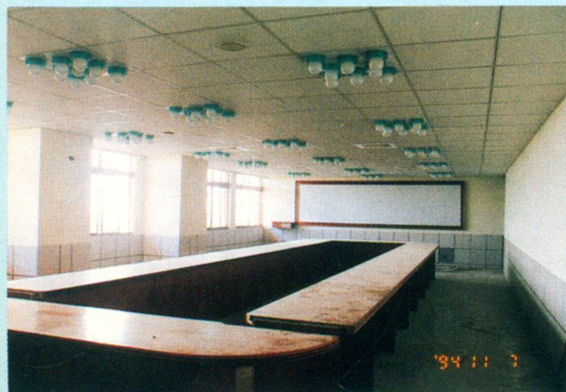
五樓會議室將完成工程一景。
