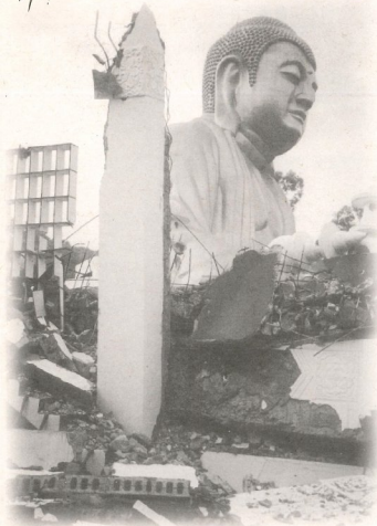
▲霧峰萬佛寺受損嚴重
