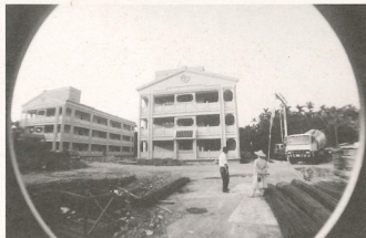
▲文殊院第一期僧寮重建工程
