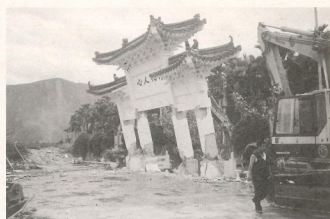
▲文殊院拆除山門遺址
