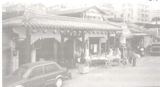
▲蓮池庵原有建築
