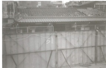
▲市府興建市民大道將山門先行拆除並將正門封閉，出入均由後門出入
