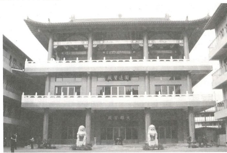
▲新建鐵爐寺大雄寶殿
