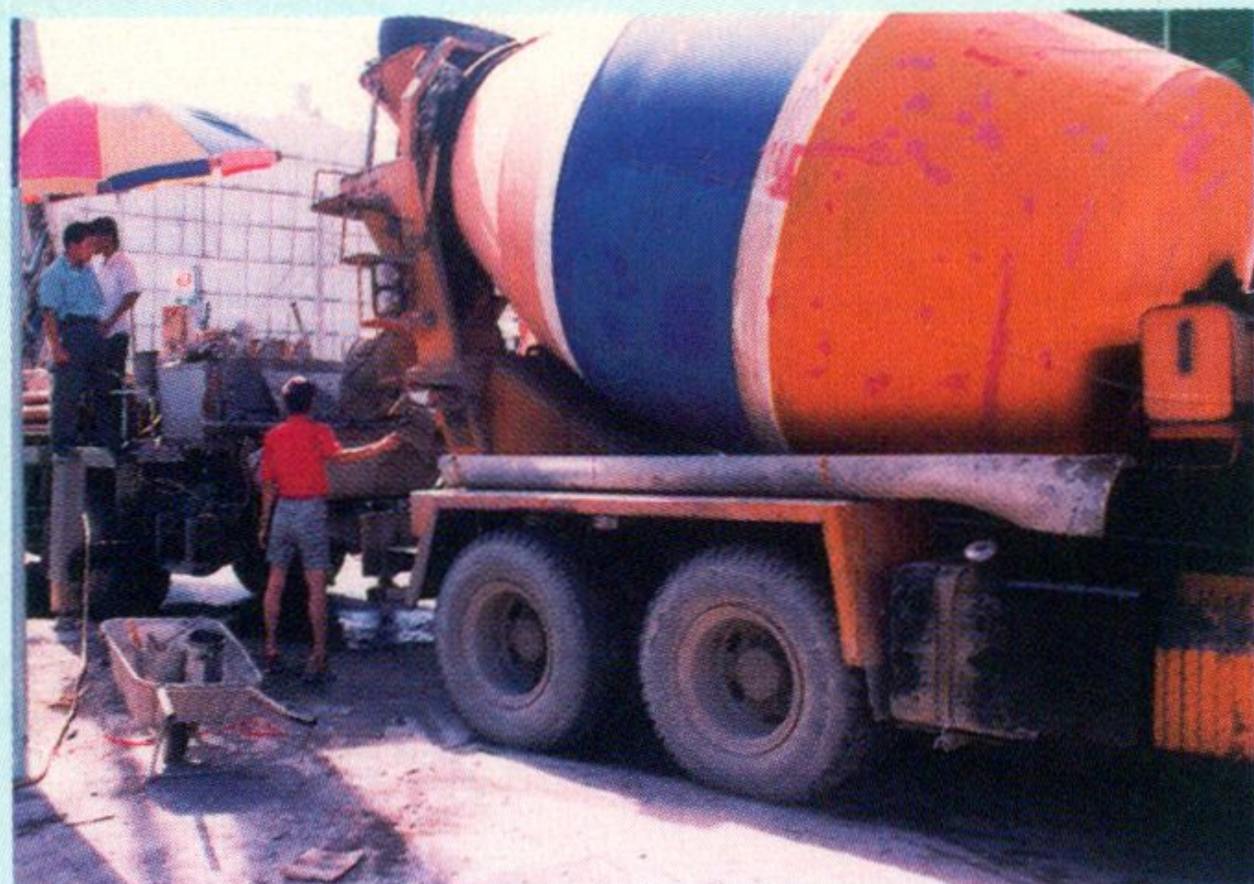
這是運滿攪拌現成的水泥車，相繼運到講堂工地施工現況。
