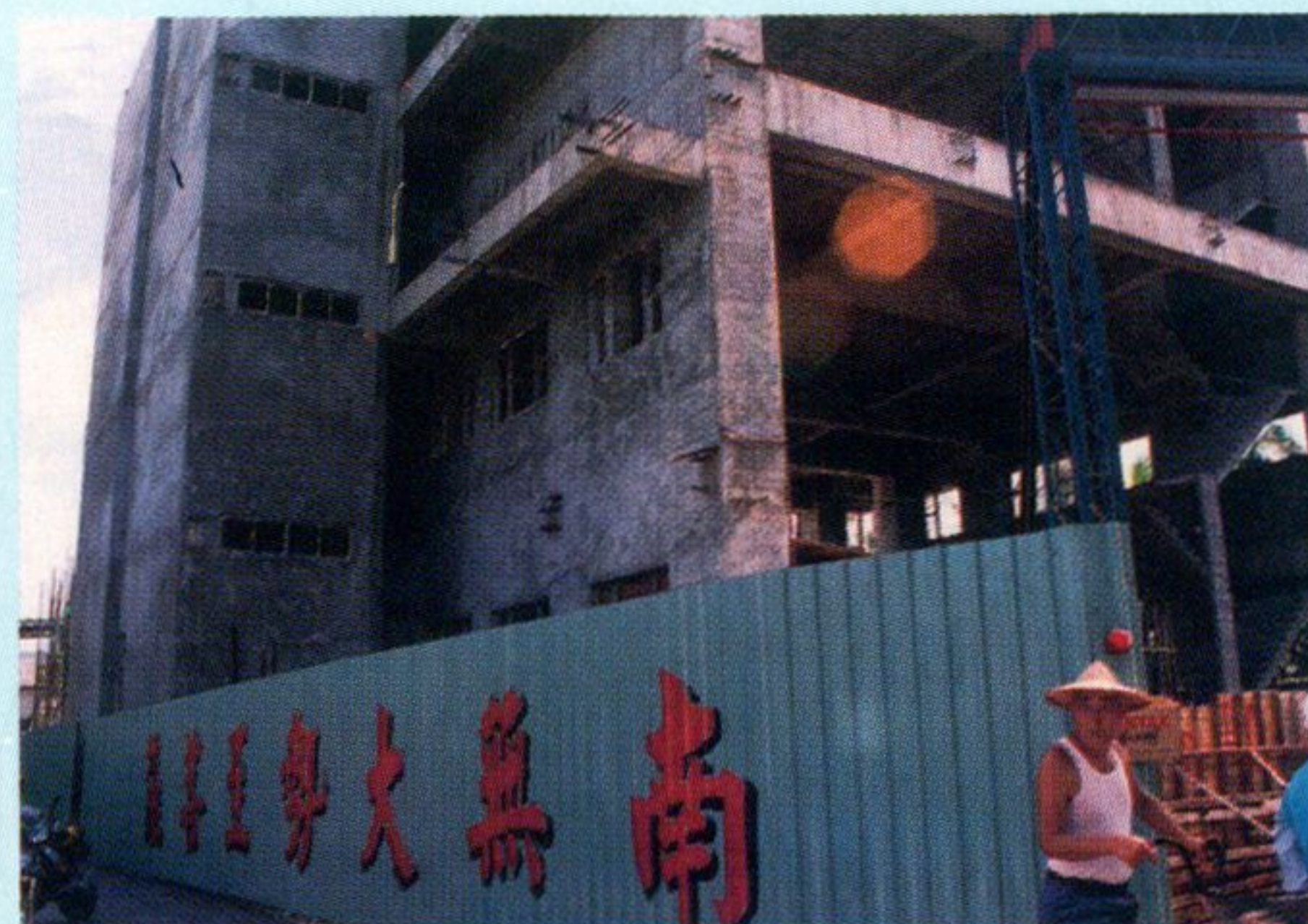
講堂工地外圍安全設施，由一層鐵皮所護持著。
