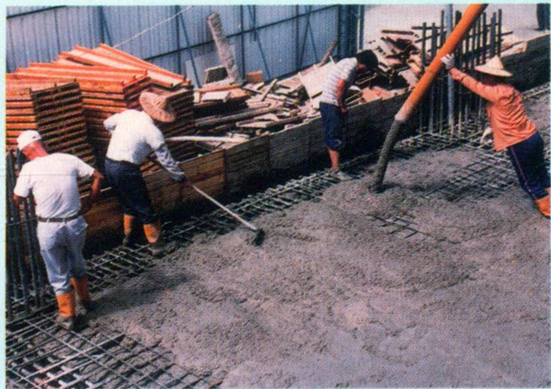
工作人員在烈日下辛勤施工。
