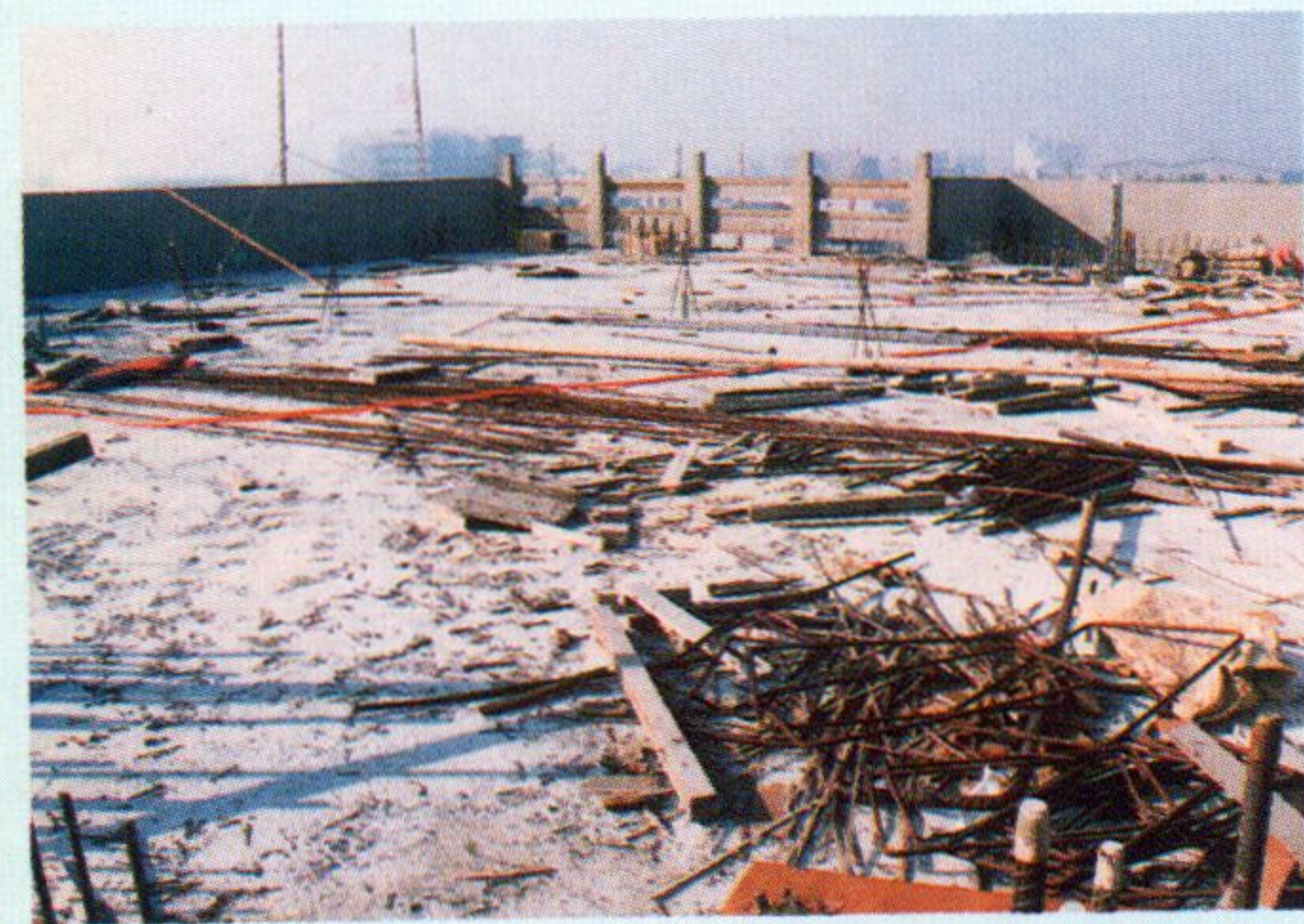
這是講堂屋頂，正進行工程的部份。
