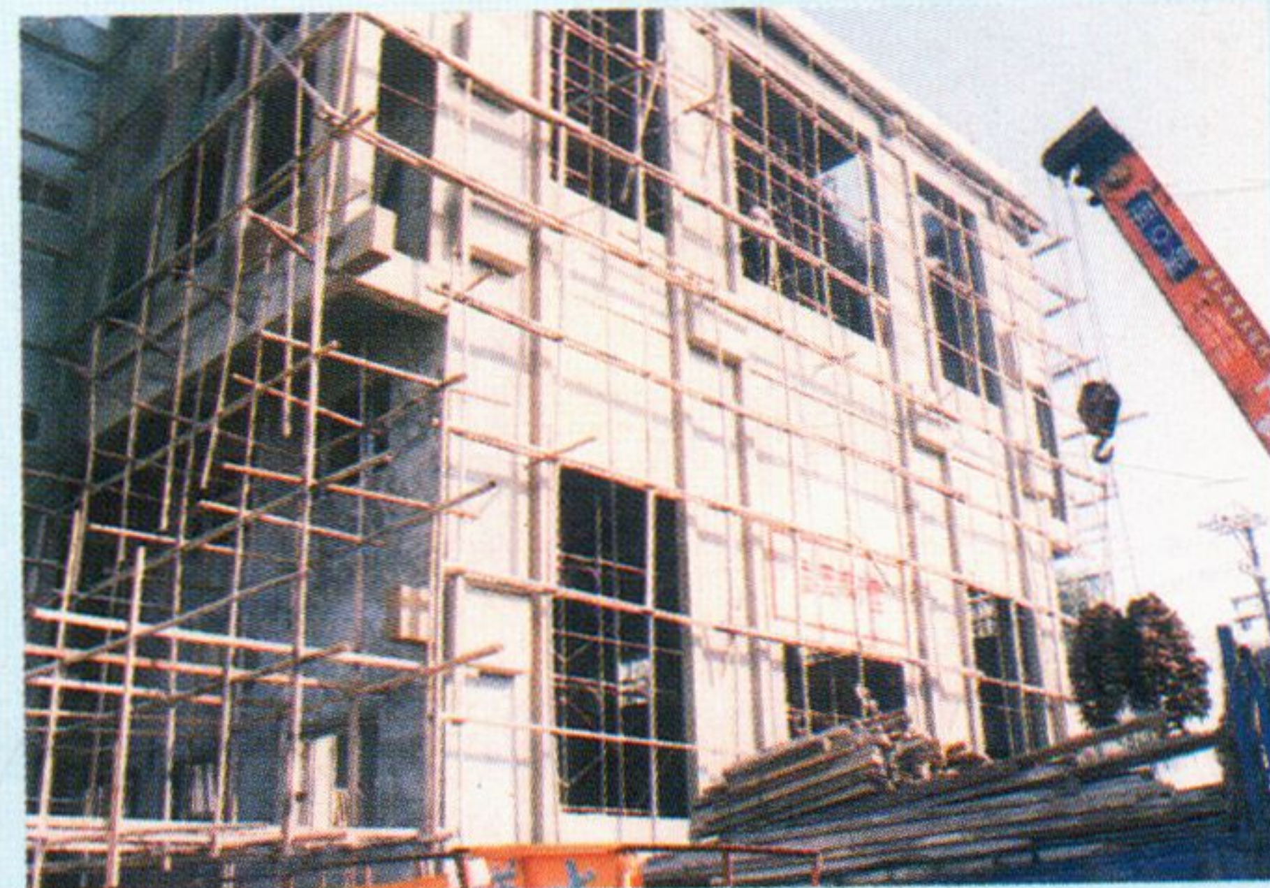
正進行工程建造一景，願善信大德理念三寶，廣植福田，讓講堂早日圓成，廣度眾生！
