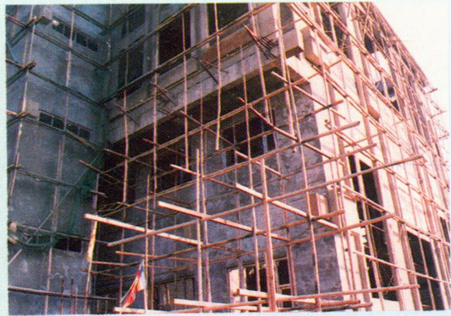
如期的法王講堂大樓，已興建至二樓與地下室二層。
