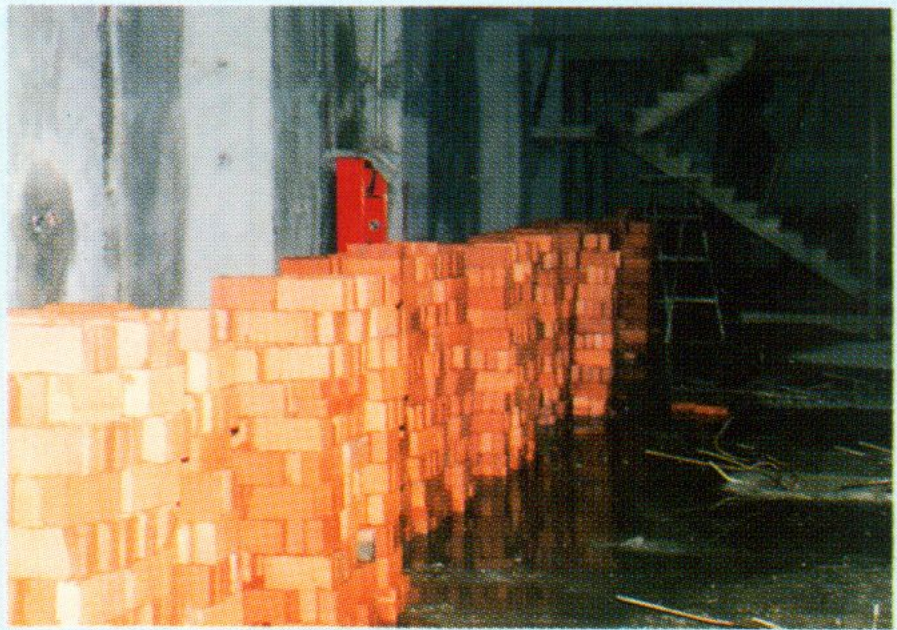
這是地下室堆積的磚塊，正進行塗水泥之一隅。
