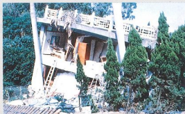
▲萬佛寺禪房建築傾斜情形
