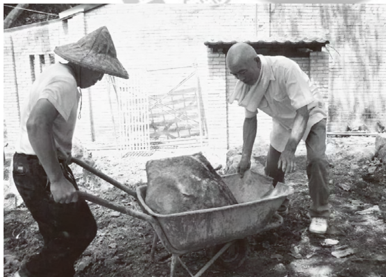
園區整地工程，靠著志工們發心護持、胼手打理而完成。
