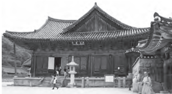
通度寺大雄殿四面檐下分別有「大雄殿」、「寂滅寶宮」、「金剛戒壇」及「大方廣殿」四塊懸板，此照為大雄殿一側，其屋頂形制亦相當特別。(攝影/陳怡安)
