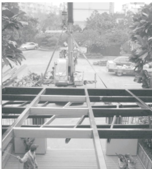
▲ 3/12 架設大殿前玻璃鋼架
