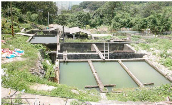
圖2: 水磨坑溪旁尚未完全破之前的水簸場。
