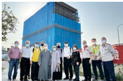
▲ 4.14 參觀安藤大師設展「光之門」大樓工地
