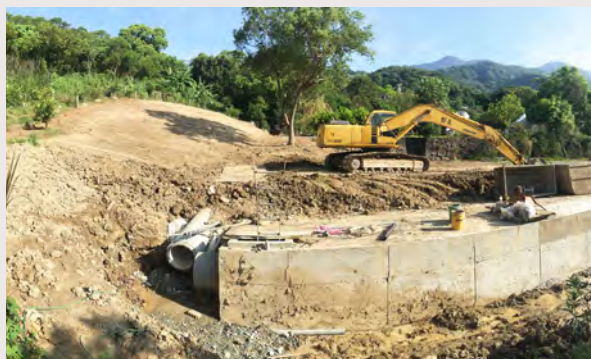
沈砂滯洪池覆土
