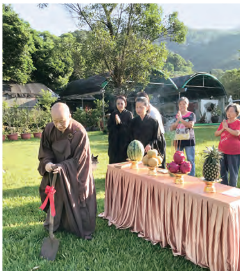
▲8.7 舉行園區簡易水土保持工程的動工儀式
