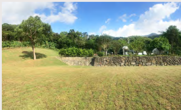
簡易水土保持工程完工
