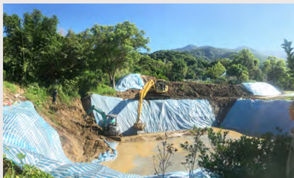
「沈砂滯洪池」開挖
