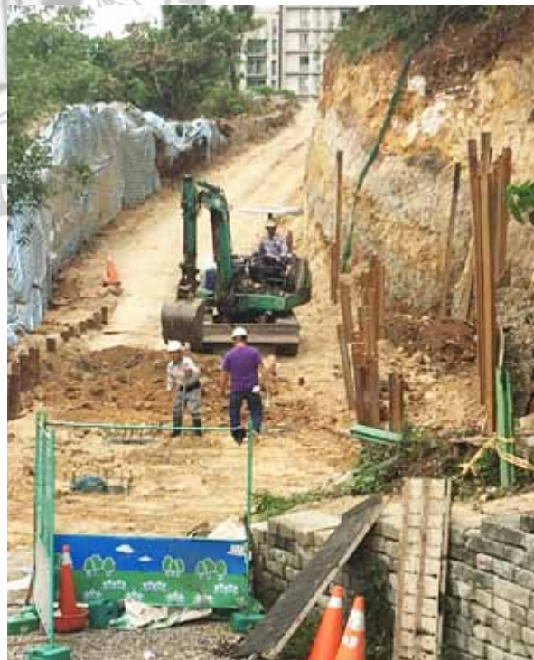
北投第22號公園道路建設
