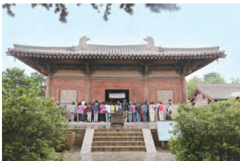
▲8/3 南禪寺為中國現存最早的中唐木構建築
