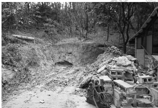
3月份北投覺風學院水土保持駁坎工程
