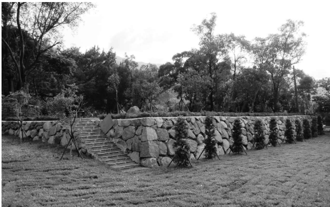
5月中旬北投水土保持及綠化工程告一段落，綠意盎然
