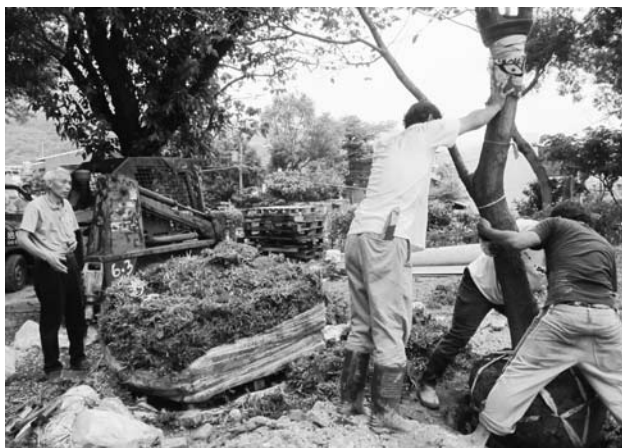
在大眾辛苦揮汗的願力下，學院進行植樹與綠化工程
